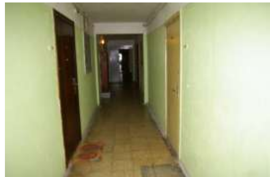
Būve ar kadastra apzīmējumu 1700 014 0180 001, koplietošanas telpa
