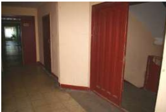
Būve ar kadastra apzīmējumu 1700 014 0180 001, koplietošanas telpa
